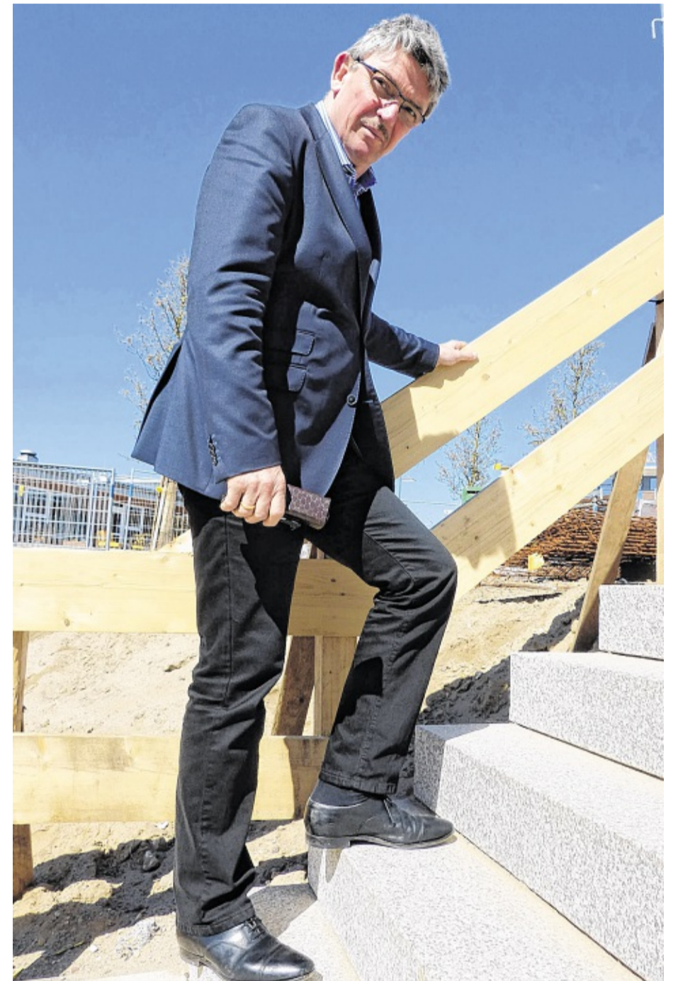
Sind die Stufen zu klein? Kritiker Ronald Büssow (SPD) steht auf der umstrittenen Treppe. Deutlich ist zu sehen, dass seine Hacke übersteht. BURY
